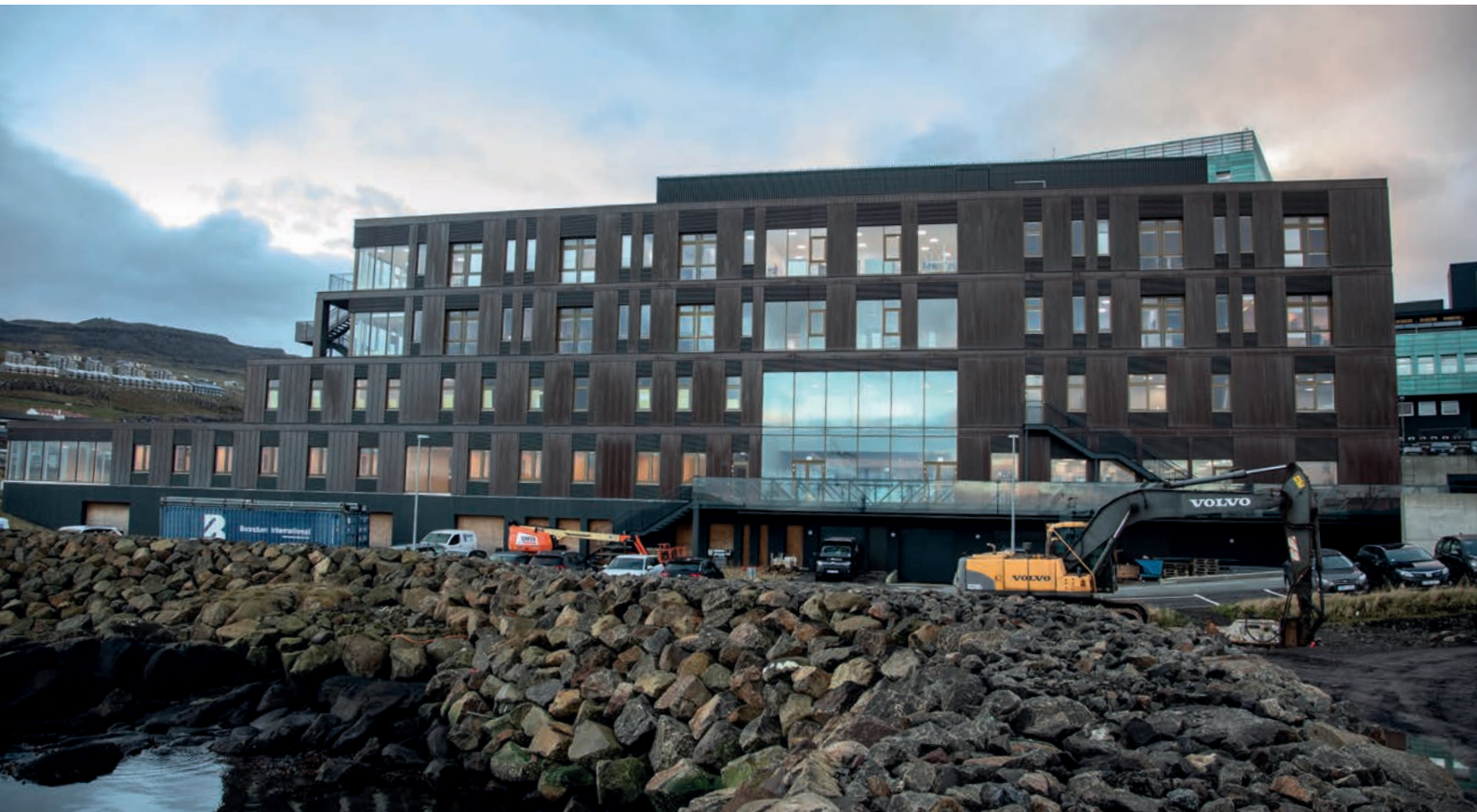
H-bygningurinn á Landssjúkrahúsinum
